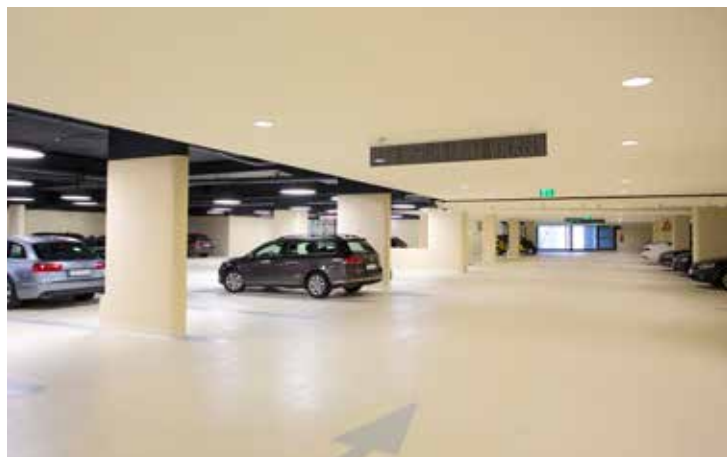
Bild 2 - Fahrbahn und Stellplätze der eingeschößigen Tiefgarage
